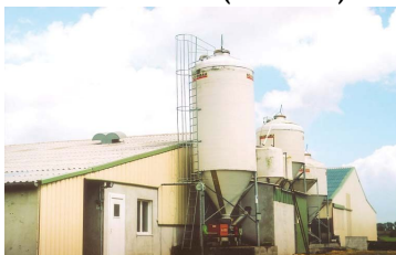
Silo « tour » (aliments)
